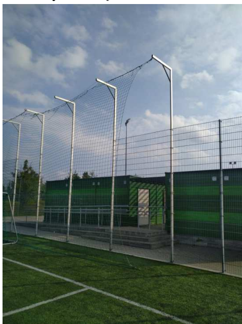
Fot. Poglądowy sposób montażu piłkochwytów za bramkami.
